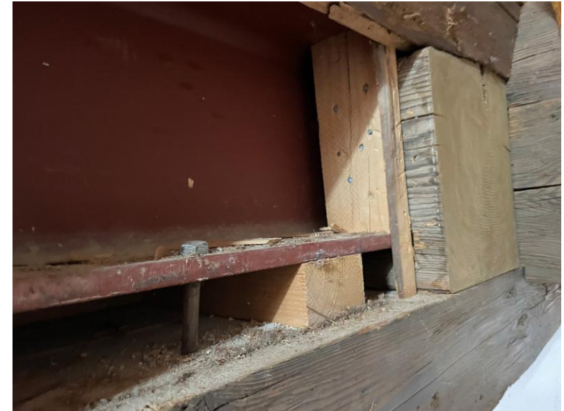
Stahlträger in Decke über EG
