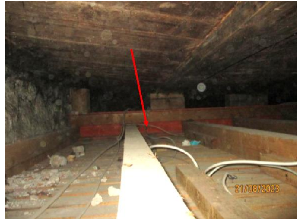
Holzbalkendecke über EG mit Stahlträger verstärkt
